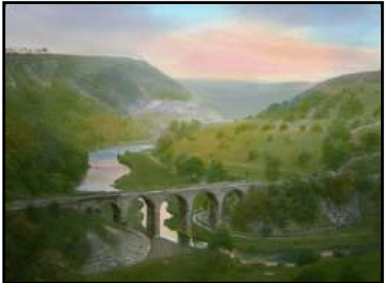
Monsal Viaduct. (J.W.Jackson, 1930's)
